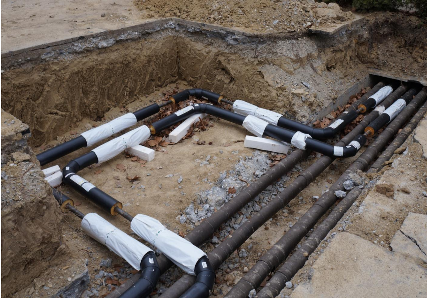
Kép: szekunder vezetékek kiváltása új primer vezetékekkel
