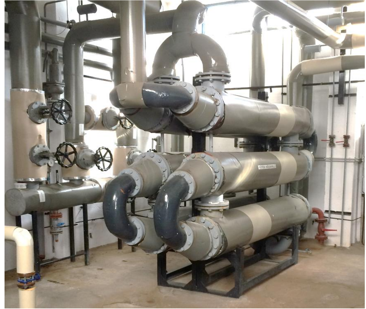
Kép: rossz hatásfokú építőelemes hőcserélő
