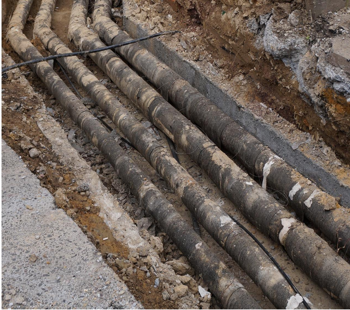
Kép: elavult állapotú szekunder vezetékek
